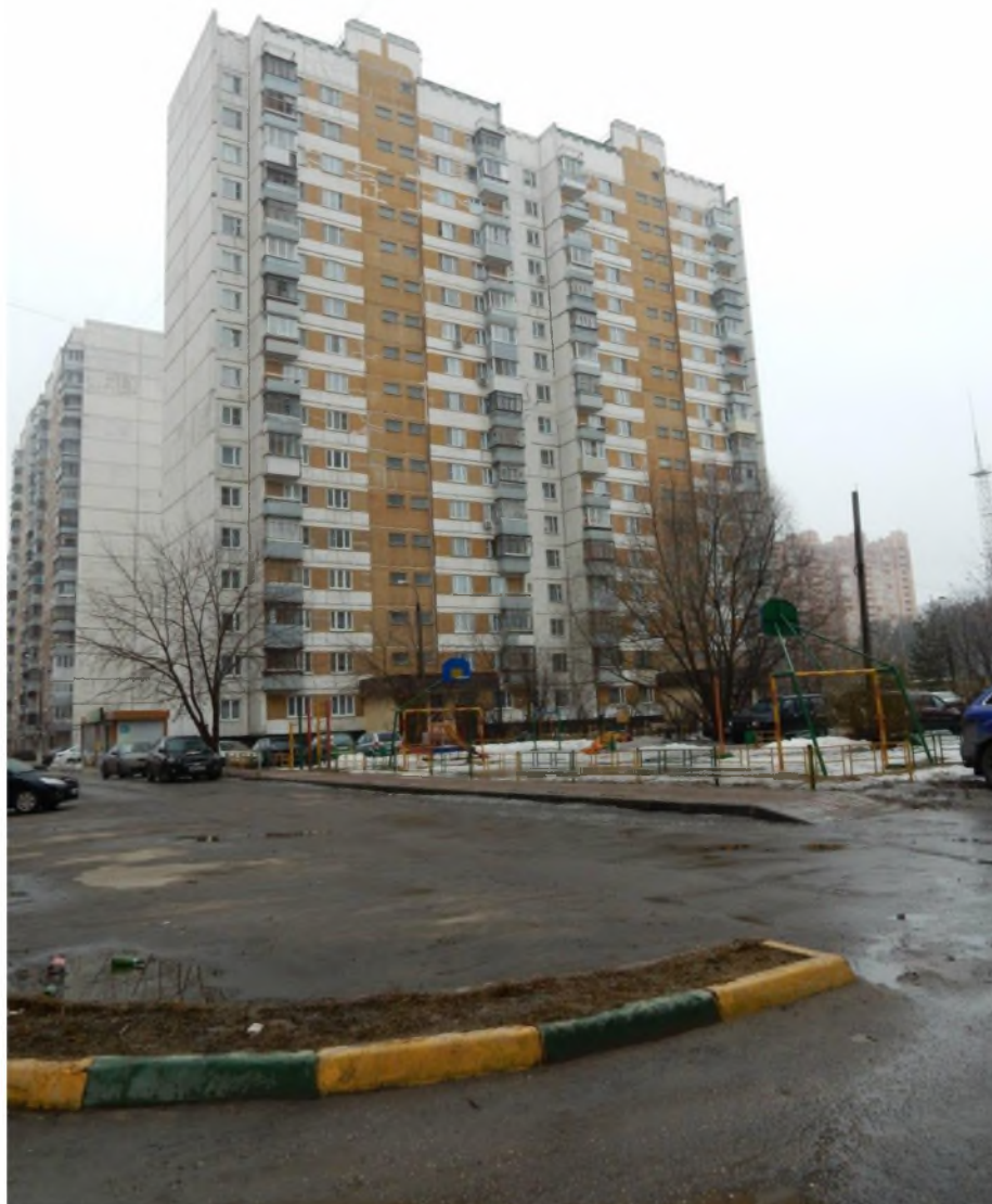
Рисунок 4 – Фотофиксация существующего состояния территории
