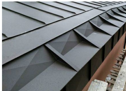
Устройство водосборного желоба на фальцевой кровле. Ендова Устройство водосборного желоба на карнизе
