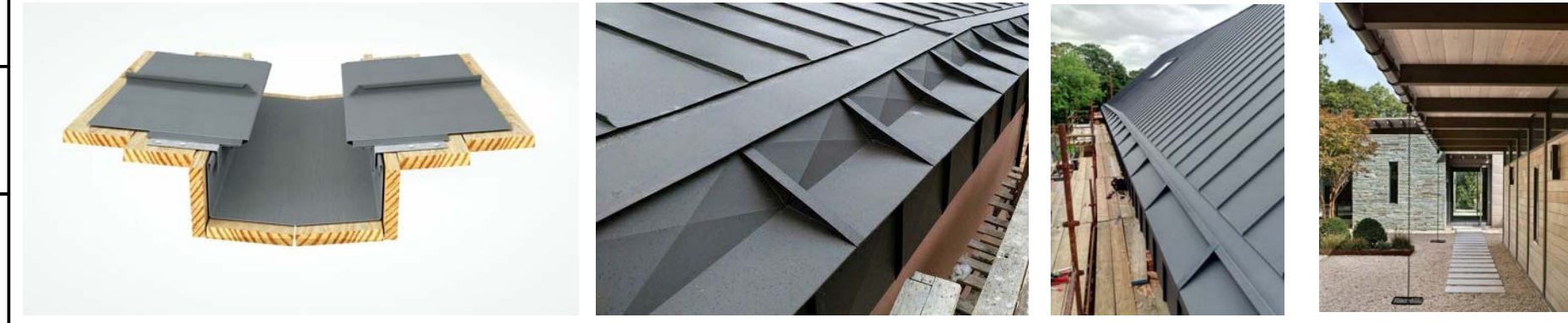
Устройство водосборного желоба на фальцевой кровле. Ендова Устройство водосборного желоба на карнизе Открытый водослив по цепочке
