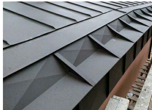
Устройство водосборного желоба на карнизе
