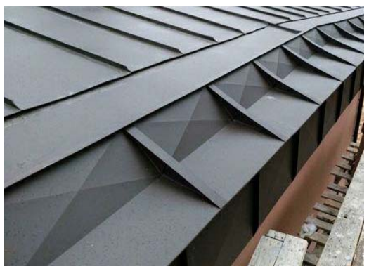
Устройство водосборного желоба на карнизе
